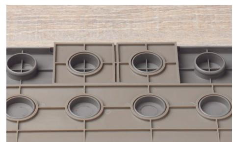
**4** Coloque os conectores quadrados e retangulares, como ilustrado na imagem abaixo. Pode encaixá-los com a sua mão, mas também pode colocar a placa batente de plástico preta no conector de encaixe e bater com um martelo até fixar no lugar. Certifique-se de que a superfície por baixo é sólida e plana. Utilize sempre a placa batente!
