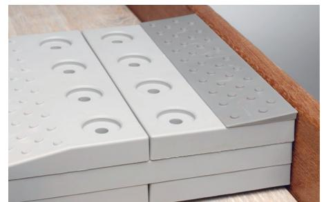
Posez la demi-dalle oblique de travers sur une partie de la dalle. Fixez-la d'un solide coup de marteau (utilisez toujours la plaque de frappe). Déterminez la hauteur la plus adaptée et indiquez l'endroit où la dalle oblique devra être découpée si nécessaire. Des lignes de découpe sont prévues sur les dalles.
