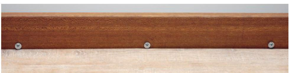
Utilize as aberturas feitas para determinar onde os parafusos devem ser montados, altura de 10 mm do piso.
