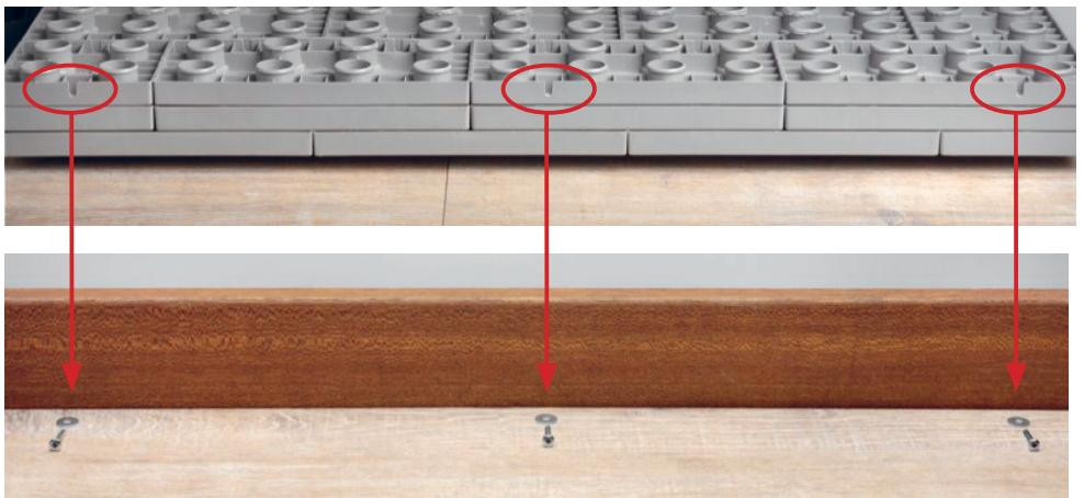
À travers les évidements ainsi créés, marquez l'endroit où les vis devront être fixées, à une hauteur de 10 mm du sol.
